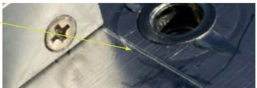
Schieben Sie nun das nächste Modul unter den Modulhalter und richten Sie es an den Zusatz-Endhaltern aus. Anschließend können die Modulhalter und die Zusatz-Endhalter angezogen und ein weiteres Modul aufgelegt werden. (Anzugsmoment 15-20 Nm).
